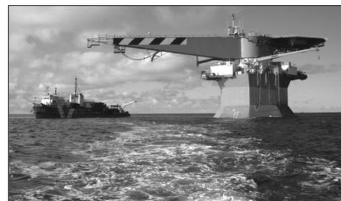
**Барандей.** Нефтяной терминал фирмы «Лукойл» (Алекперов) в Баранцевом море. Предназначен для отгрузки в танкеры нефти, добываемой в этом субъекте федерации. Стоит в 22 км от берега для обеспечения необходимых для подхода танкеров глубин. Введен в эксплуатацию по постоянной схеме в 2008 г. К нему тянется 158-километровый трубопровод от месторождения Южное-Хильчюу (его эксплуатирует совместное предприятие «Лукойл» и «СопосоPhillips»). Мощность месторождения 7,5 млн т нефти в год.
